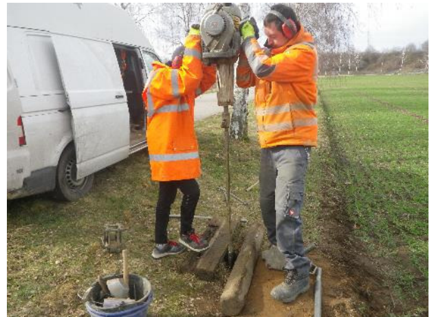
Foto 4: Rammkernsondierung bei RKS 2 / DPH 2
