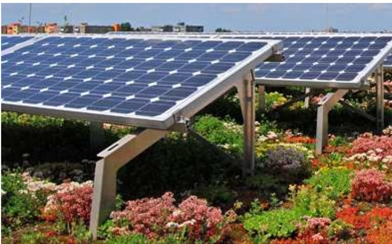
**Abb. 22** Kombination von Dachbegrünung und PV-Anlage (<https://www.zinco.de/solar>)
