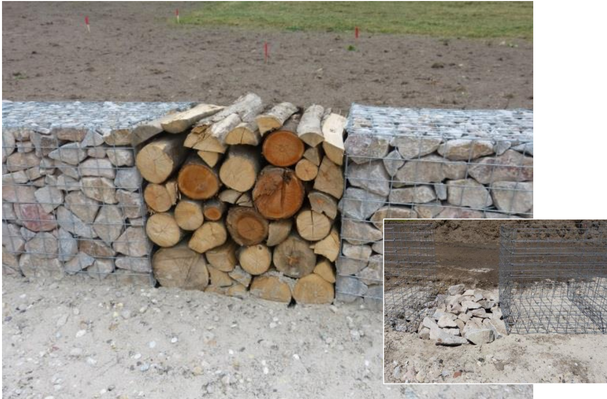
Bild 3: Ersatzhabitat für Mauereidechsen in Form von Gabionen (unter den Holzstapeln wurde 0,5 m tief Schotter eingebaut (kleines Bild) und am Gabionenfuß grabfähiges Sediment zur Eiablage angebracht).
