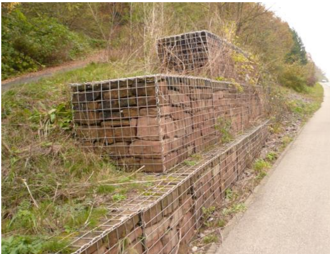
Bild 4: Ersatzhabitat für Mauereidechsen als stufenförmiger Bau von Gabionen.
