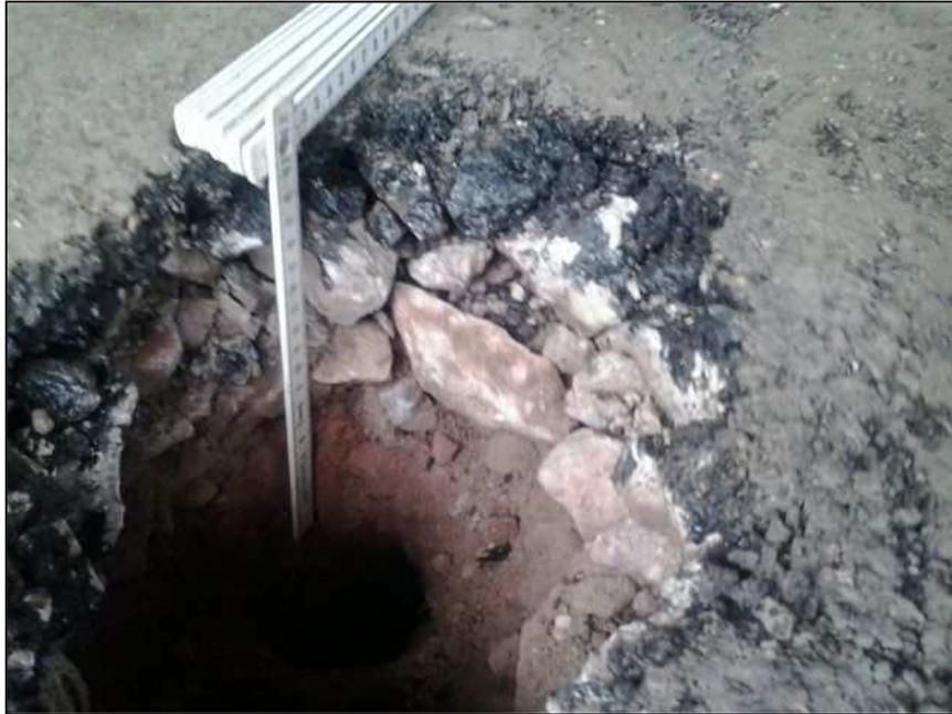
**Abb.1** Teerspritzdecke / mit Teer gesprühte Schotter in Sondierung Bk 1
