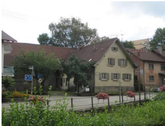
Risiko: Baulicher Zustand von ortsbildprägenden Gebäuden an der Yburgstraße
