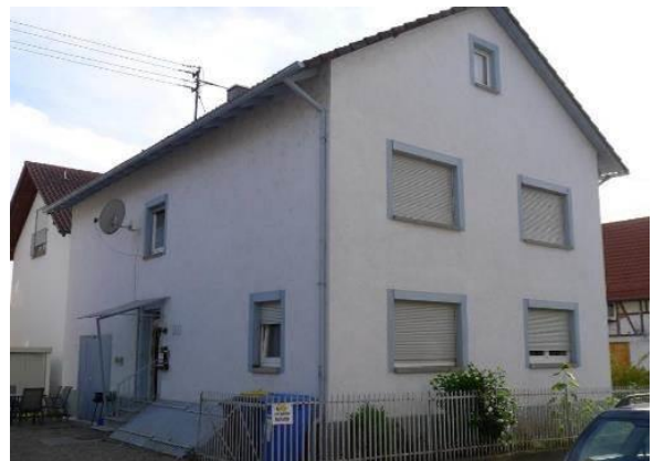
Umbau Einfamilienhaus durch Umbau des Speichers zu einem Zweifamilienwohnhaus, Steinbach, 2016
