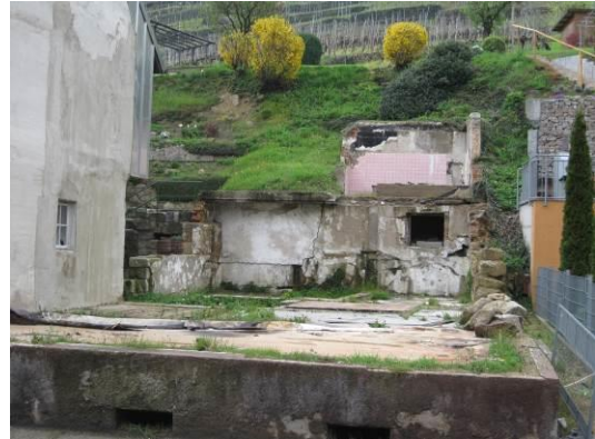
Schwäche: Bauruinen entlang der Ortsdurchfahrt
