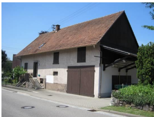
Chance: Umnutzung ehem. Ökonomiegebäude zu Wohnraum
