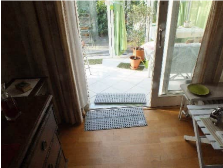
Steckrampen aus Kunststoff; hier nicht optimal geeignet.
