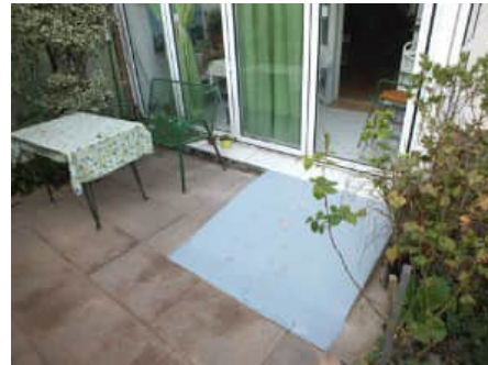
Stolperfalle zur Terrasse? Anbetonierte Rampe, auch für Rollator besser geeignet.
